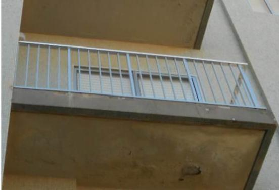
Grades existentes nas varandas localizadas nos 1º ao 10º andar com as dimensões de 1,10 m (h) x 4,25 m (l).
