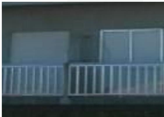
Painel existente na divisória das varandas localizadas no rés-do-chão com as dimensões de 1,00 m (h) x 1,50 m (l).
