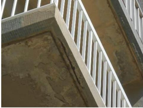
Zona de betão danificado com armadura exposta em tecto de varanda.
