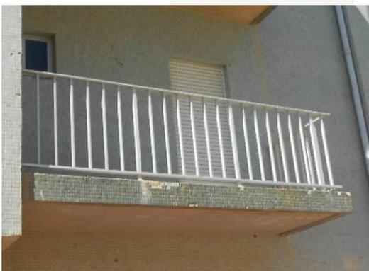
Grades existentes nas varandas localizadas nos 1º ao 10º andar com as dimensões de 1,10 m (h) x 4,65 m (l).
