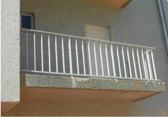
Grades existentes nas varandas localizadas nos 1º a 10º andar com as dimensões de 1,10 m (h) x 4,65 m (l).
