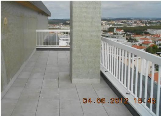
Grades existentes nos terraços dos arrumos na cobertura com as dimensões de 1,10 m (h) x 35,65 m (l).
