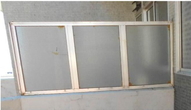
Painel existente na divisória dos terraços localizados no rés-do-chão com as dimensões de 1,00 m (h) x 2,30 m (l).
