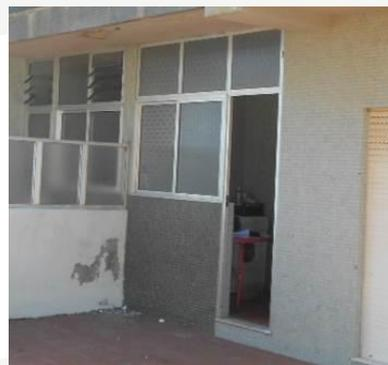
Caixilharia constituída por dois elementos com as dimensões de 1,64 m (h) x 1,47 m (l) e com as dimensões de 2,11 m (h) x 0,72 m (l) localizada no rés-do-chão junto ao terraço exterior.
