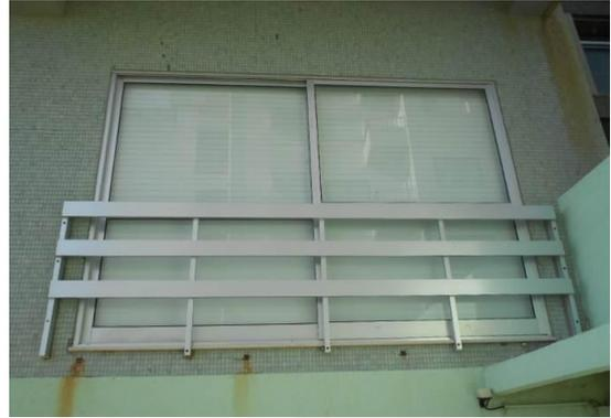
Grade existente no vão exterior localizado no rés-do-chão, por cima da rampa de acesso à garagem do edifício, com as dimensões de 0,95 m (h) x 2,80 m (l).
