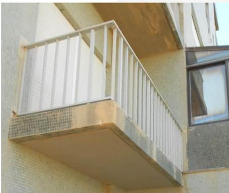
Grades existentes nas varandas localizadas nos 1º ao 10º andar com as dimensões de 1,10 m (h) x 4,25 m (l).
