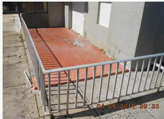
Grade existente no terraço localizado no 1º andar e que contorna o edifício pelo alçado principal com as dimensões de 1,10 m (h) x 16,65 m (l).
