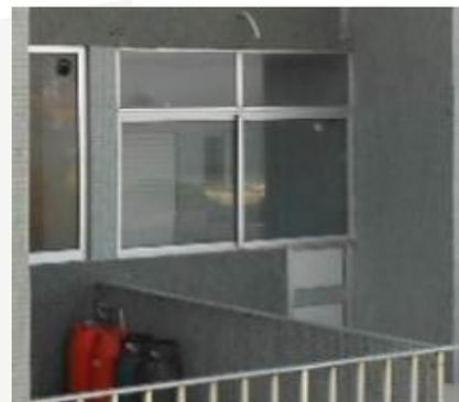
Caixilharia constituída por dois elementos com as dimensões de 1,67 m (h) x 2,39 m (l) e com as dimensões de 0,90 m (h) x 0,65 m (l) localizada no terraço por cima da entrada principal.
