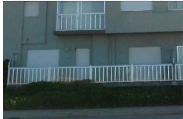
Grade existente na varanda localizada no rés-do-chão com as dimensões de 1,10 m (h) x 10,55 m (l).
